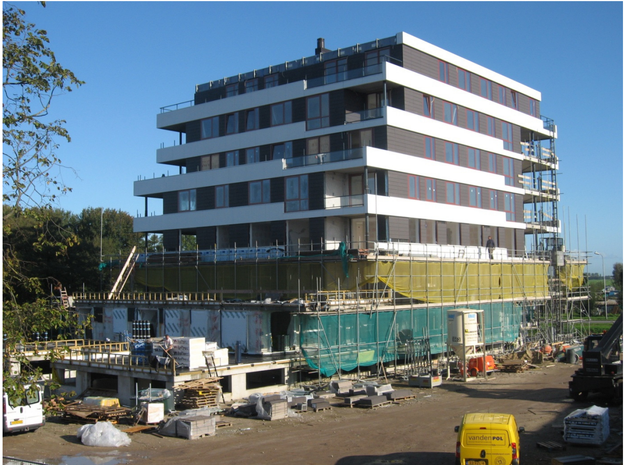
Het gebouw in aanbouw
