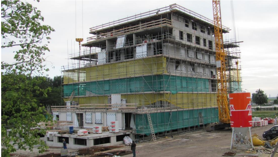
Het appartementencomplex in aanbouw
