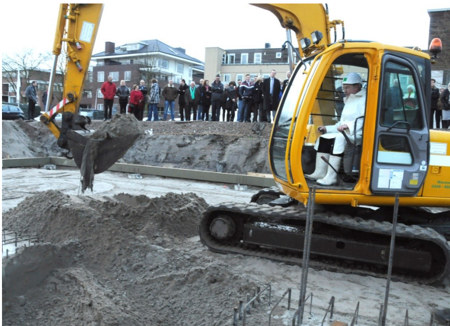
Foto: wethouder Hans Vroomen aan het werk in de graafmachine
